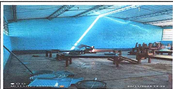
Foto 5: Se realiza la pintadas en el interior de la escuela.
