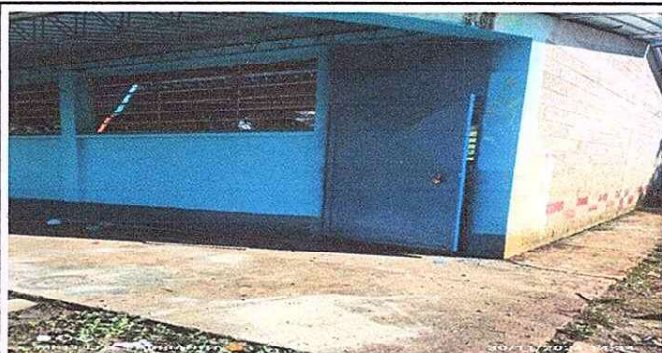
Foto 4: Se instalaron puertas de la escuela.
